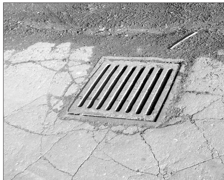
Podczas kontroli będą sprawdzać przyłącza w studzienkach
