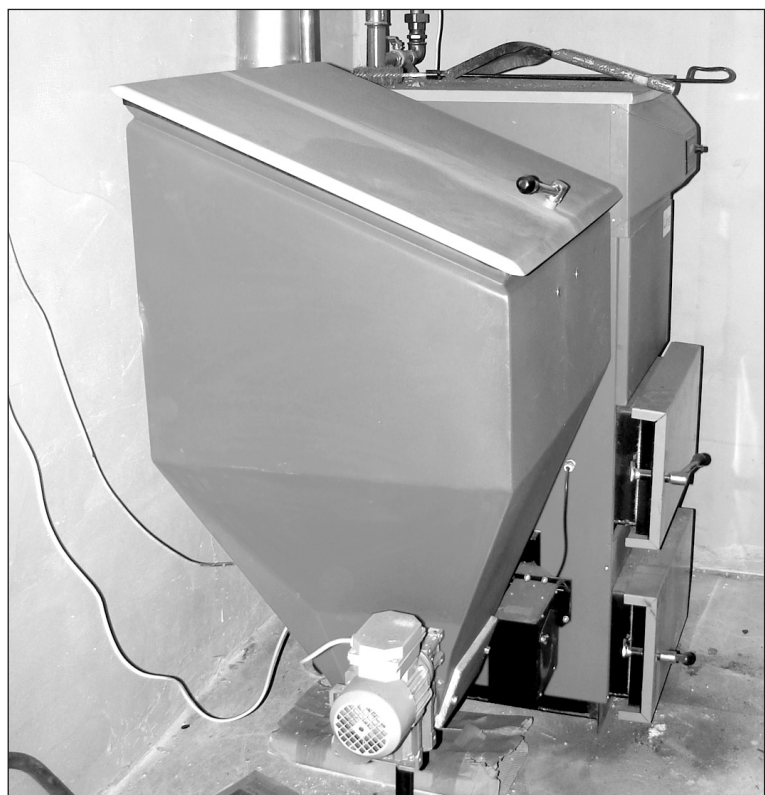
Nowoczesna kotłownia z piecem ekologicznym wygląda tak. Wystarczy dokładać do niego raz na tydzień.
