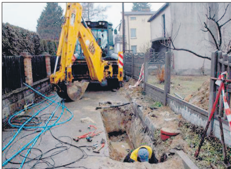
Na Porzeczkowej wodociąg wymieniono już zimą.
