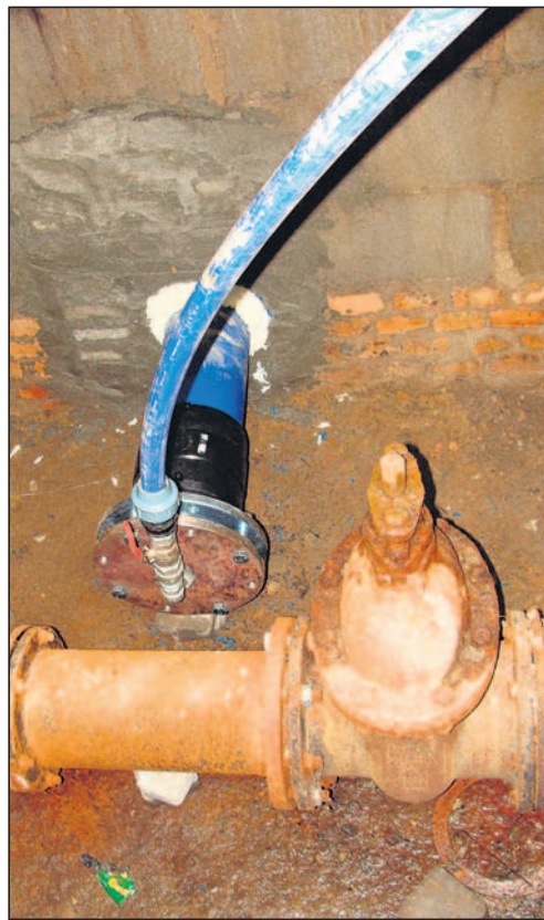
Stare rury wodociągowe ustępują miejsca nowym.
