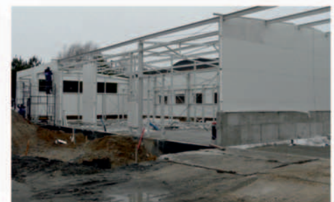
Budynek techniczny - montaż ścian
