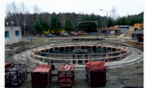
Osadnik wtórny - modernizacja
