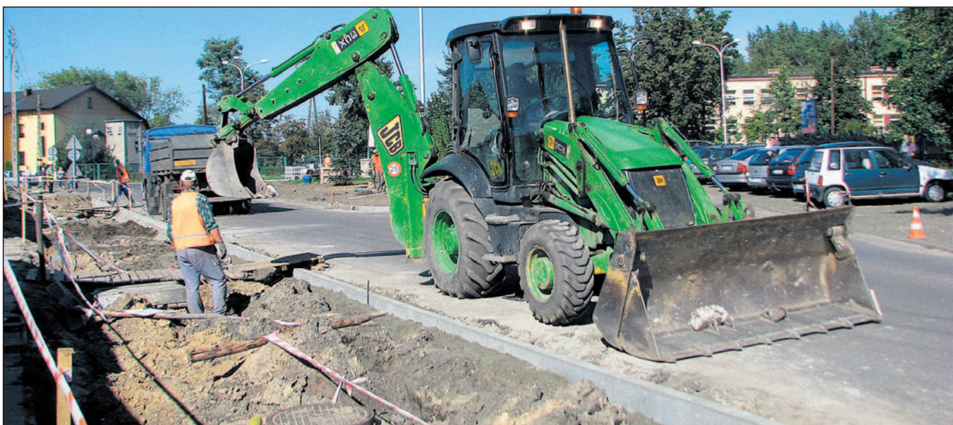
Budowa kanalizacji przy ul. Fredry. Do 2014 roku tak, a nawet bardziej rozkopanych, będzie wiele ulic miasta.
