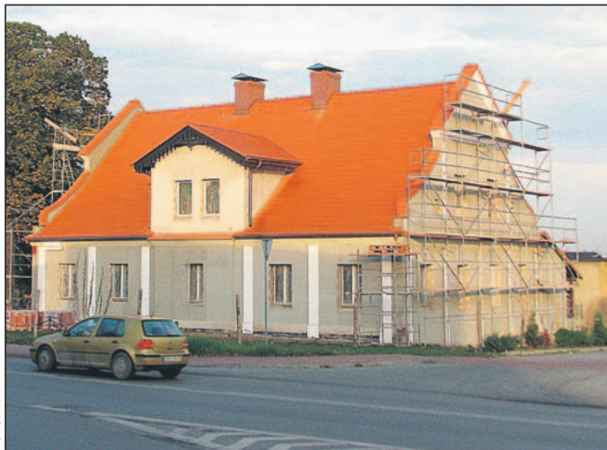
Nowy dach, odnowione mury.
