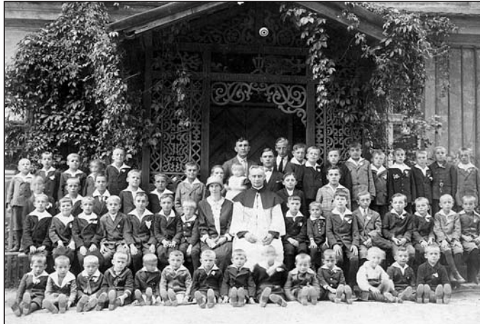
Zabytkowy ganek będzie odbudowany.
