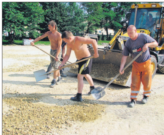
Brygada R. Walczucha nakłada warstwę kruszywa.
