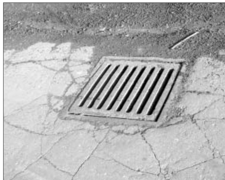
Podczas kontroli będą sprawdzać przyłącza w studzienkach
