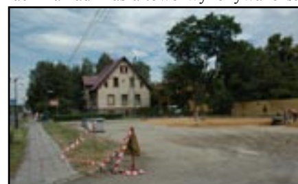
Trwa budowa parkingu przy skrzyżowaniu ulic Hołdunowskiej i Palmowej
