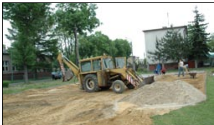
Budowa parkingu przy Gimnazjum Nr 2
