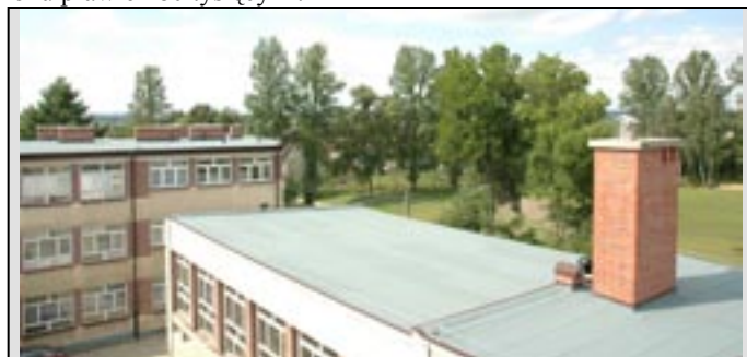
Nowe pokrycie dachowe SP1 - największa tegoroczna inwestycja w tej placówce
