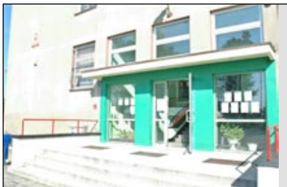
Nowe drzwi frontowe SP 3 wraz z przeszklonymi gablami unowocześniły wizerunek szkoły
