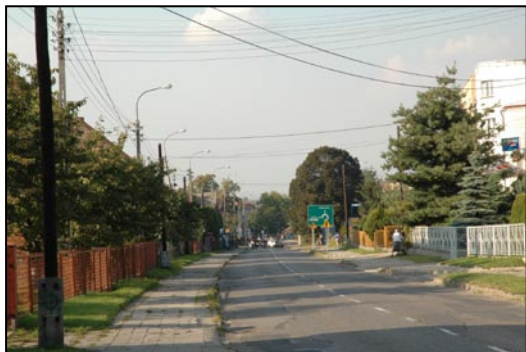
Ulica Łędzińska. W wyniku odrzucenia wniosku do UE remont tej drogi powiatowej realizowany będzie etapami. Najważniejsze jest jednak to, że remont oczekiwany od tak dawna nareszcie będzie mógł się rozpocząć.
