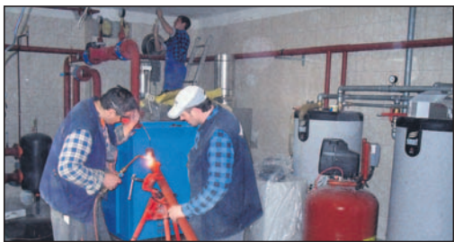
Prace związane z montażem nowoczesnej kotłowni gazowej.
